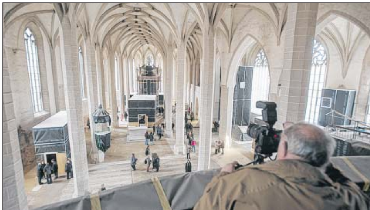
Etwa 1 300 Gäste aus nah und fern nutzten am 23. März den Tag der offenen Baustelle, um einen Blick in den Bautzener Petri-Dom zu werfen. Seit Oktober 2013 wird das simultane Gotteshaus innen umfangreich saniert. Bevor diese Woche das Innengerüst bis unter die Gewölbendecke erstellt wird, war am Sonntag die letzte Gelegenheit, den Dom als Baustelle zu sehen und zu fotografieren. Die Sanierung dauert bis Ende 2015 und soll circa 2,1 Millionen Euro kosten. Fotos: SN/M. Bulang
